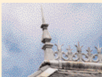
◀ Epi de faîtage et crête en zinc.
