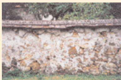
▲ Mur plein en maçonnerie de meulière.
