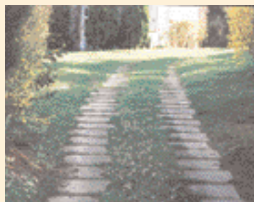
L'accès des voitures est matérialisé seulement par des dalles de béton posées sur l'herbe avec un léger décalage. ▶
